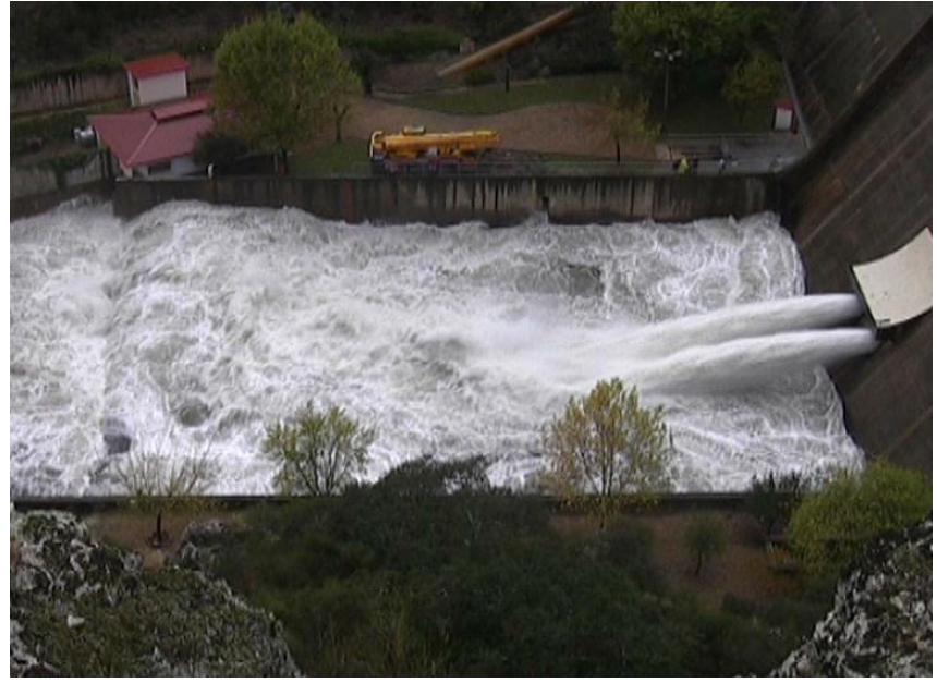
Villar del Rey dam outlet bottom
